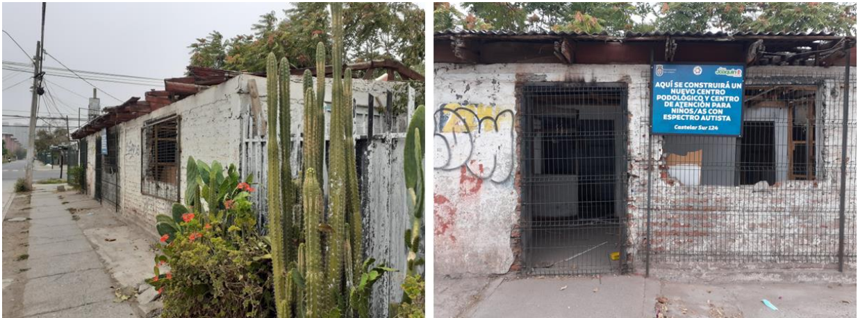
Ilustración 53. Fotografías de terreno en calle Castelar Sur que se desafecta.
